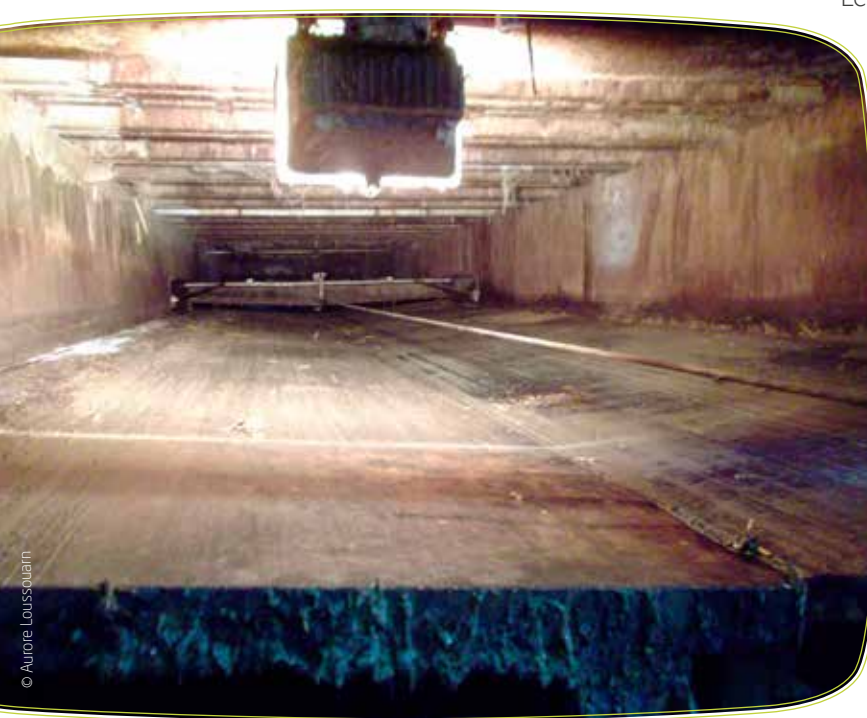
En élevage porcin, le raclage en V, installé sous le caillebotis, peut permettre de réduire jusqu'à 50 % la volatilisation d'ammoniac en séparant les phases solides et liquides du lisier directement au bâtiment (chambre régionale d'agriculture de Bretagne).
