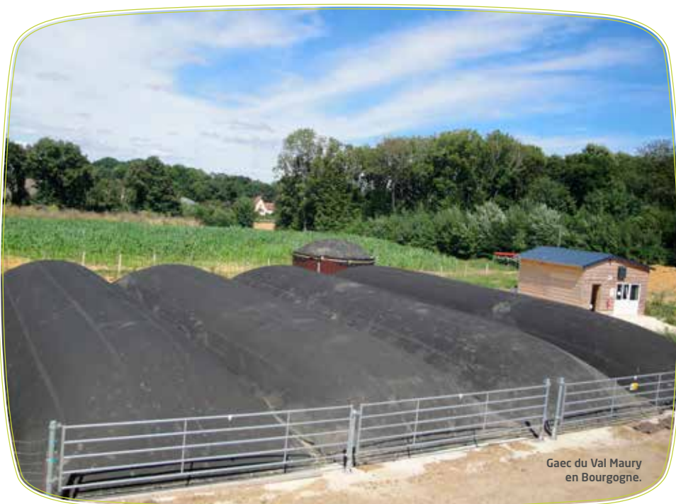
La méthanisation par voie sèche peut accepter des teneurs en matière sèche de l'ordre de 30 à 40 %. Elle est bien adaptée pour traiter le fumier en élevage bovin.
